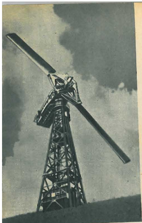
Motore a vento sperimentale Smith-Putnam costruito a Grandpa's Knob (S. U.) nel 1941; potenza nominale 1 500 kW; la parte mobile pesava 265 t; una pala dell'elica, di 55 m di diametro, si spezzò nel '45.
