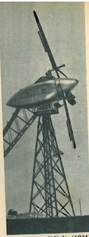
Aeromotore di Yalta (1931); 31 m di diametro; 100 kW; funzionò fino alla sua distruzione nel 1941. Produzione annua 279 000 kWh.
